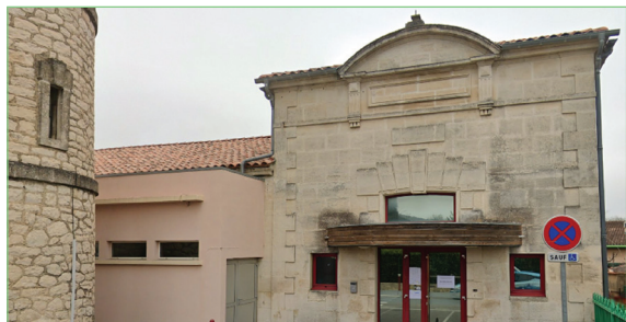
Installation d'un système de rafraîchissement dans les locaux du centre aéré
