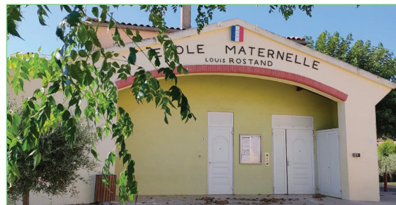
Installation d'un système de rafraîchissement dans les locaux de l'école maternelle
