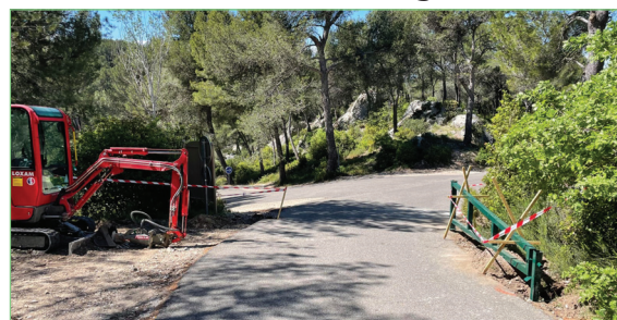
Installation d'une barrière DFCI route de Beauregard
