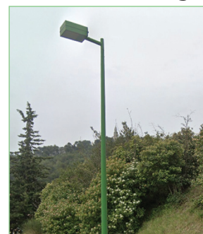
Diagnostic de l'éclairage public
